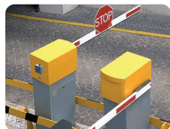
Lösung an einer Schranken-anlage mit Zutrittsicherheit. Solution at a barrier construction with access control.
